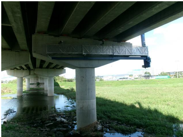
굴절점검차를 이용한 근접조사
