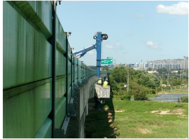
굴절점검차를 이용한 근접조사
