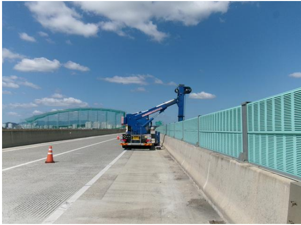
굴절점검차를 이용한 근접조사
